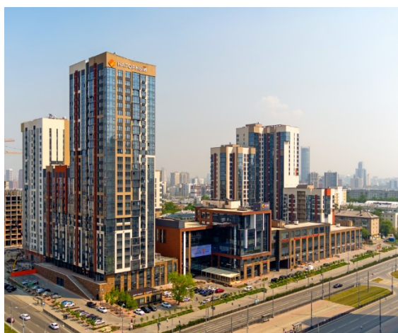
Рис. 1. Жилой комплекс «Нагорный», г. Екатеринбург
